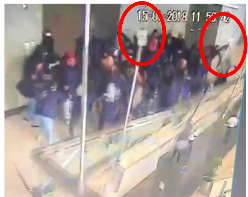
Kondisi saat kegagalan bangunan (Pukul 11:56:42 WIB) Sling terlepas/putus dari suspended bagian atas
