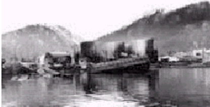
Kerusakan pada fasilitas pelabuhan di Seward, Alaska, akibat tsunami tahun 1964. Menempatkan fasilitas industri di luar wilayah terpaan adalah teknik penanggulangan yang paling efektif. Sumber: U.S Army Corps of Engineers.
