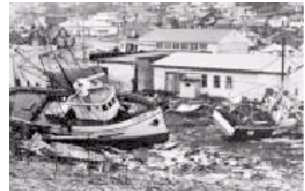
Kerusakan akibat bencana tsunami 1964 di Kodiak, Alaska. Sumber: NOAA
