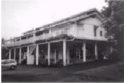
Peninggian restoran di Hilo, Hawaii. Bagian bawah dirancang terbuka untuk gelombang yang lewat. Sumber: Mintier & Associates.
