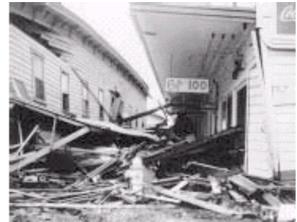
Kerusakan pada gedung di Hilo, Hawaii, akibat tsunami tahun 1946. Sumber: Pacific Tsunami Museum
