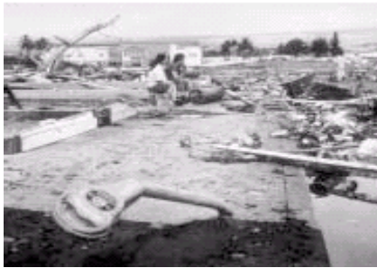
Kerusakan akibat tsunami tahun 1960 di daerah Waiakea di Hilo, Hawaii. Meteran parkir menjadi bengkok karena kekuatan gelombang yang penuh berisi reruntuhan bangunan. Sumber: US Navy
