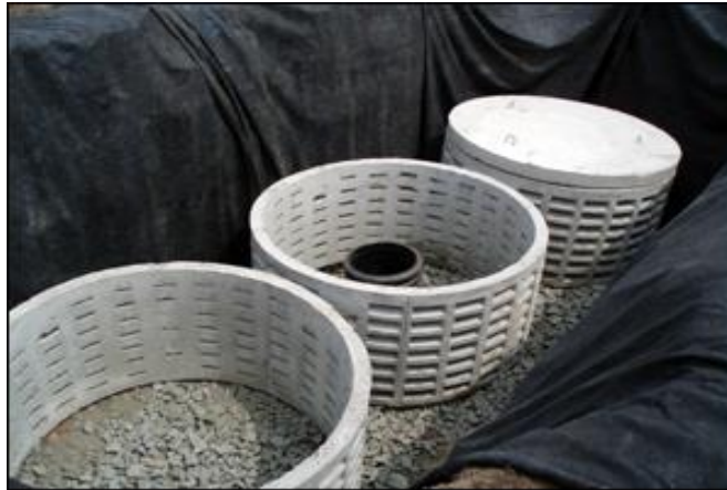
Gambar 14-2 Konstruksi Drywell dari Buis Beton
