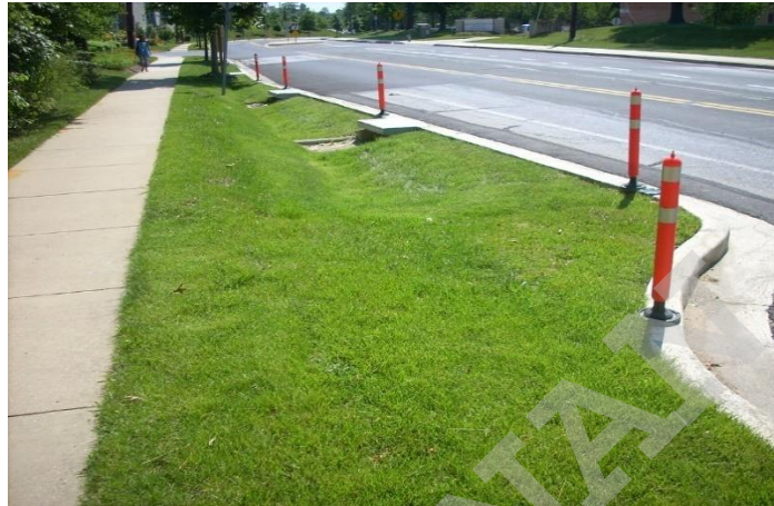
Gambar 14-4 Konstruksi vegetative Swale
